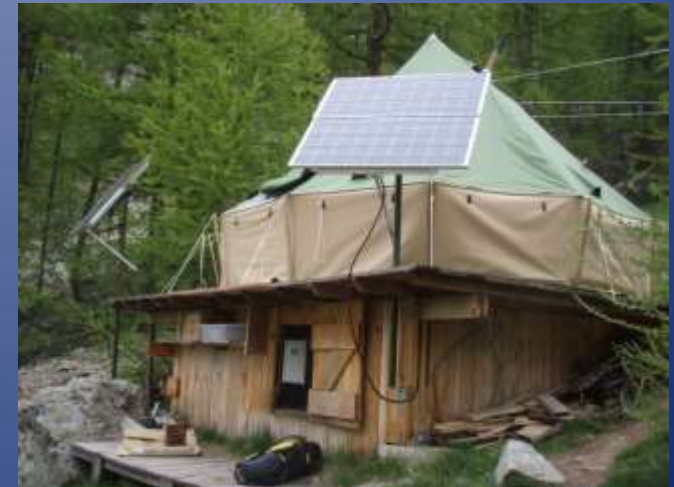
Panneaux solaires 320 W du tipi-atelier
